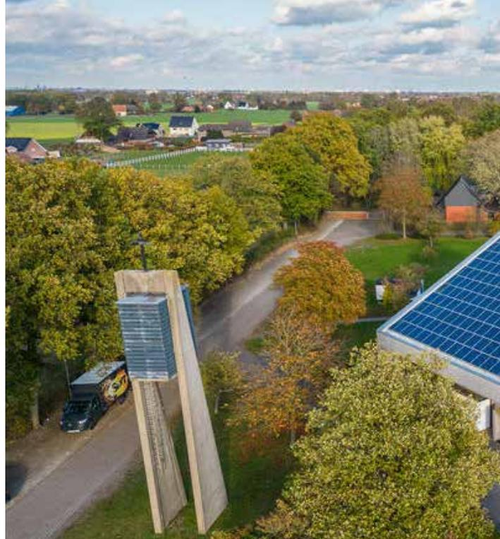
**Das Dach der 1968 gebauten Kirche in Seckenhausen bei Bremen ist vollständig mit Solarpaneelen bedeckt, der Anbau und das ehemalige Pfarrhaus ebenso. Die Anlage mit einer Gesamtfläche von 600 Quadratmetern produziert bis zu 41.000 Kilowattstunden Strom im Jahr – deutlich mehr, als die Gemeinde verbraucht.**
