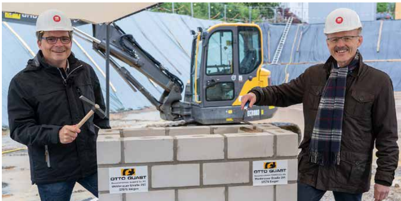
Der ERF-Vorstandsvorsitzende Jörg Dechert und der Aufsichtsratsvorsitzende Jürgen von Hagen legen den Grundstein für das neue Gebäude
